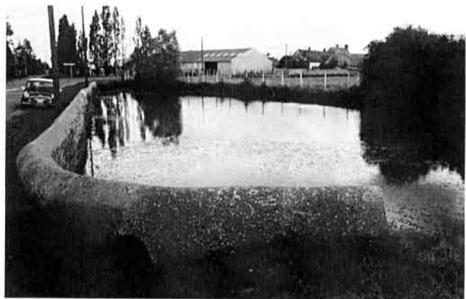
Photo 1 : Vue générale de la mare d'Ormoy en 1993 avant les travaux
